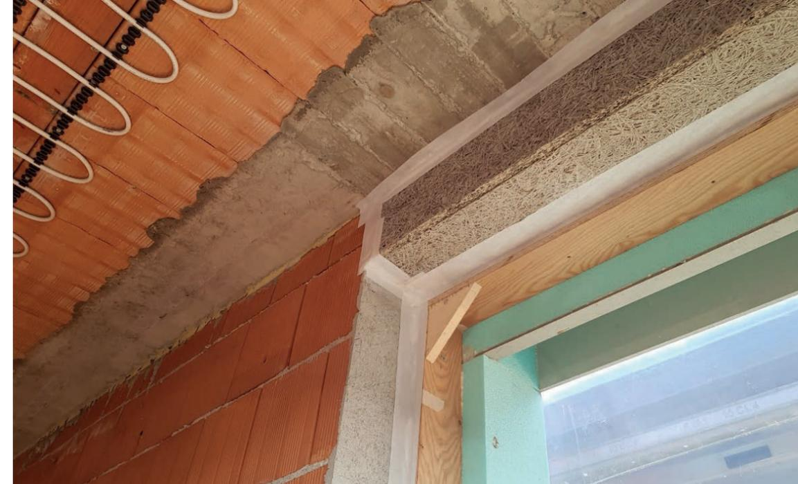
La tenuta all'aria verificata con **blower door test** eseguito a fine lavori è stata garantita anche in fase di installazione dei falsi telai monoblocco e di realizzazione degli impianti adottando specifici accorgimenti tecnici.
