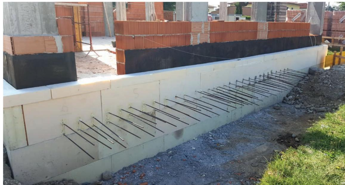
Riduzione del ponte termico nei collegamenti tra strutture orizzontali.
