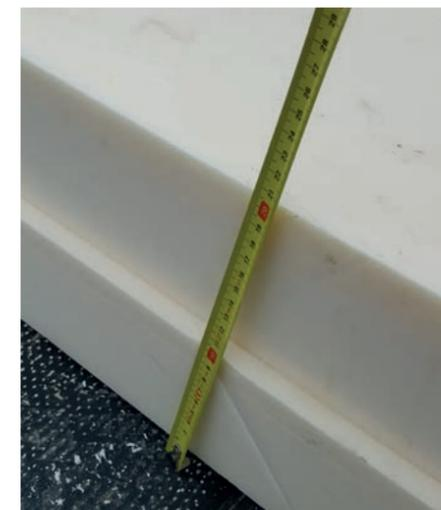
Xps 700 kPa posizionato sotto la platea di fondazione e isolamento delle murature perimetrali interrato.
